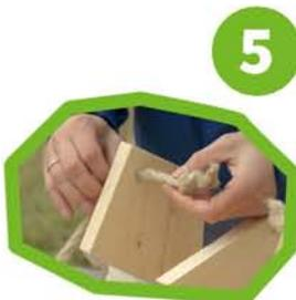
**5** Für die Aufhängung: Einen Knoten in das Seil machen. Das offene Ende von innen nach außen durch das erste Loch im Seitenteil führen. Nun von unten durch das erste Dachloch, von oben durch das zweite Dachloch und zum Schluss von außen nach innen durch das zweite Seitenteil. Hier einen zweiten Knoten als Abschluss machen.
