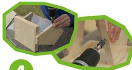
Plexiglasscheiben an die Seitenwände montieren. Danach Trennwand einsetzen und fest verschrauben. Nun in die Dachspitze zwei dicke Löcher für das Seil bohren (jeweils ca. 2 cm Abstand vom Rand), sowie je eins in die Seitenteile.
